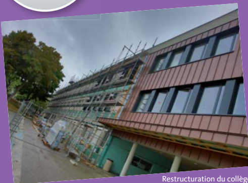
Restructuration du collège René-Descartes à Fontenay-le-Fleury
